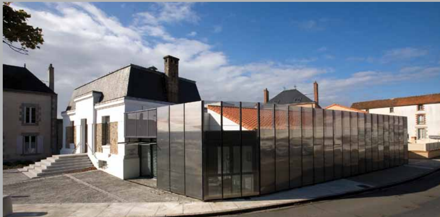
Rathaus von L'Herbergement, Frankreich / Architekt: Michel Joyau Profil 300 - Abstand 5 mm - Träger 10 x 2 mm - Achsabstand 50 mm
