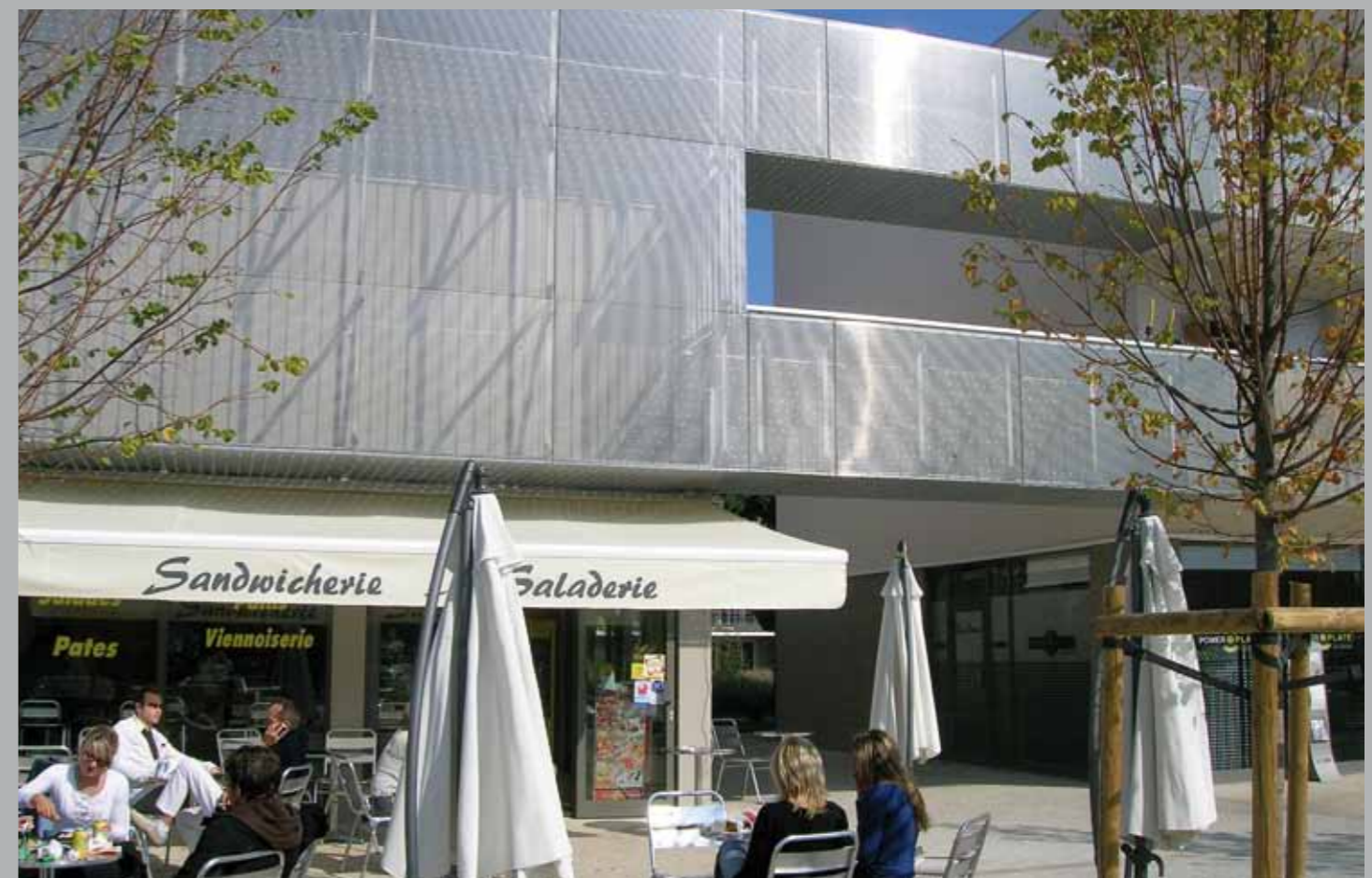
Agroparc, Avignon, Frankreich / Architekt: Georges Varnitzky Profil 560 - Abstand 10 mm - Träger 25 x 2 mm - Achsabstand 150 mm
