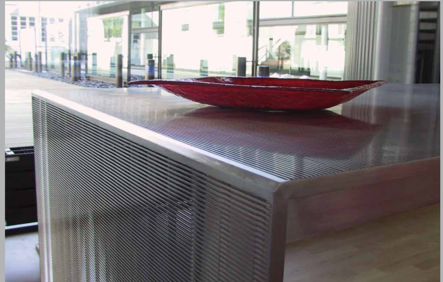
Rathaus von Trélazé Frankreich / Architekturbüro "Lipa & Serge Goldstein" Profil 220 - Abstand 2.2 mm - Träger 10 x 2 mm - Achsabstand 50 mm
