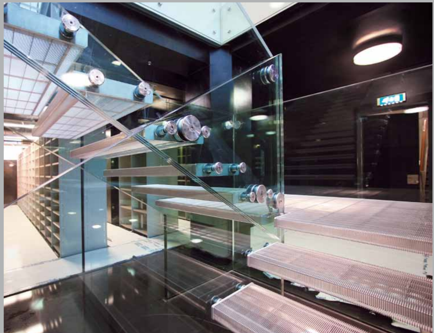
De Basel-Bücherei, Holland / Architekt: Claus En Kaan Profil 220 - Abstand 3 mm - Träger 15 x 2 mm - Achsabstand 50 mm
