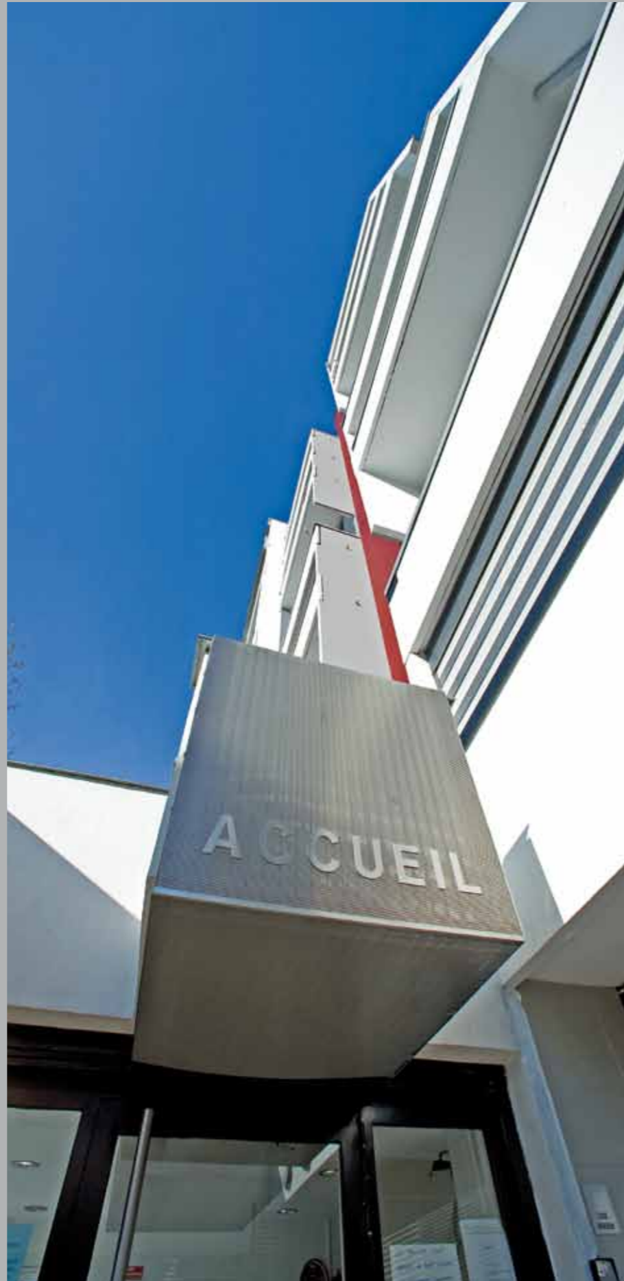
Wohnkomplex Salvador Allende, Villetaneuse, Frankreich / Architekturbüro "Lipa & Serge Goldstein" Profil 220 - Abstand 2.3 mm - Träger 10 x 2 mm - Achsabstand 50 mm
