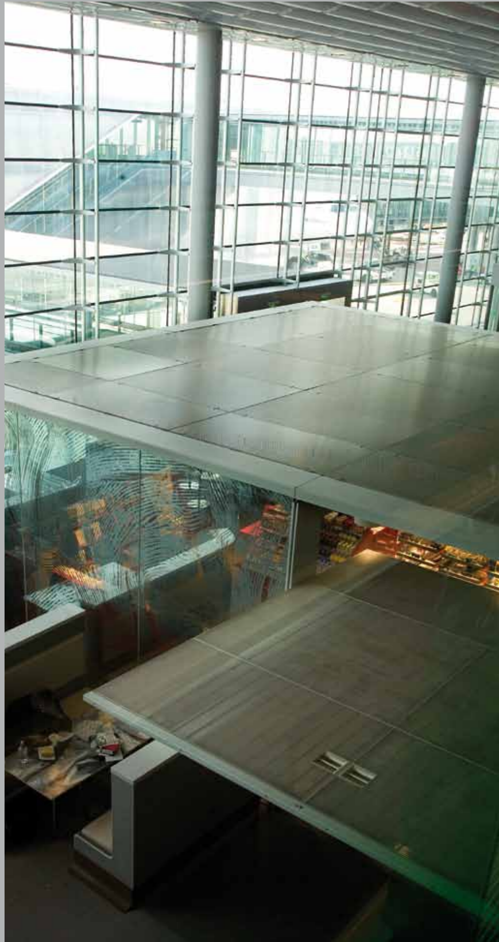
Flughafen Charles de Gaulle, Satellitenterminal 3, Frankreich / Architekturbüro "Verre & Metal" Profil 560 - Abstand 5 mm - Träger 30 x 2 mm - Achsabstand 100 mm
